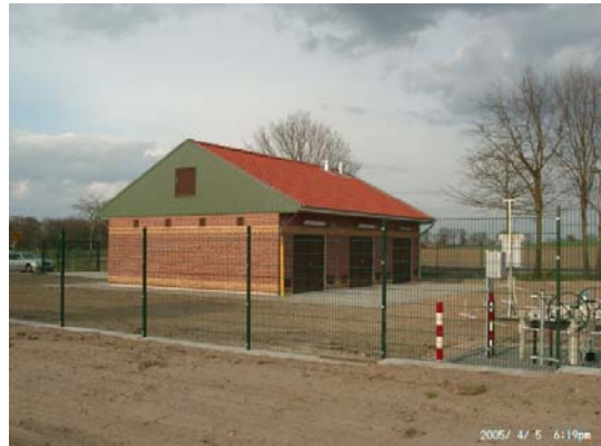
Neubau Station mit drei Beton-Fertigteilelementen, vorn: Kopfstation Pipeline-Anschluss
