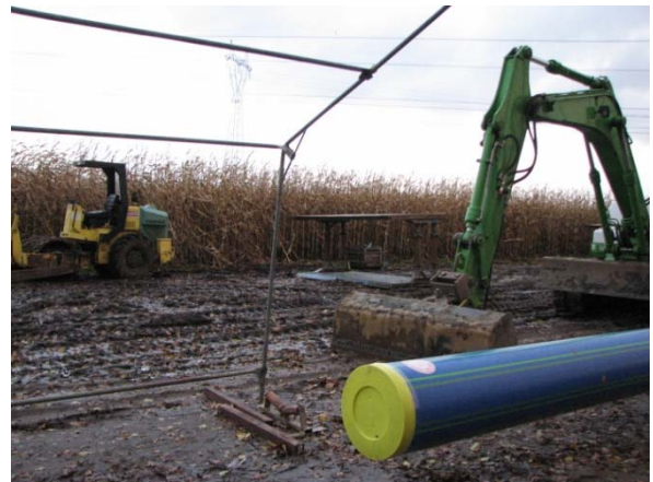
Vorbereitung der Trasse, Zelt für Schweißarbeiten
