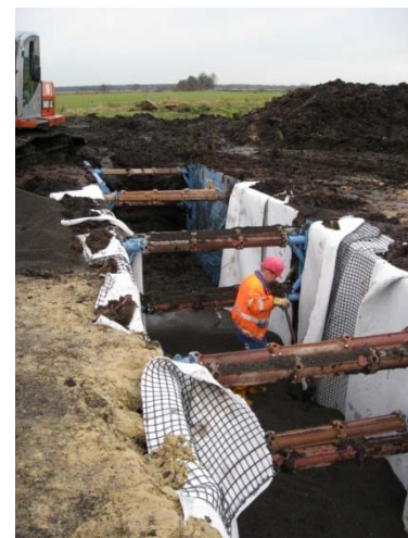
Rohrgraben im tiefen Moor mit Vlies, Geogitter, Geoton und Füllsand für lagerechten Einbau
