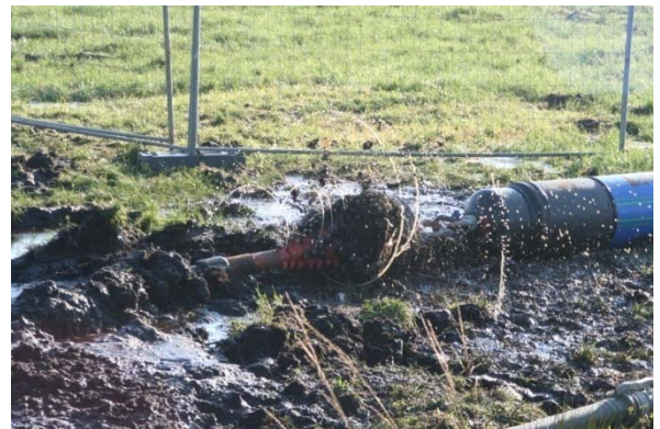
PE 100-Druckrohr mit Räumer beim Einzug HDD-Bohrung
