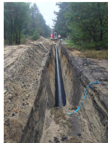
Rohrgraben im mittelsandigen, standfesten Waldboden
