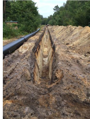
Rohrleitungstrasse, PE100-Druckrohre 560 mm SDR 17
