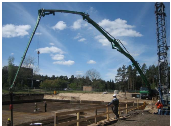
Betonage Sohle
