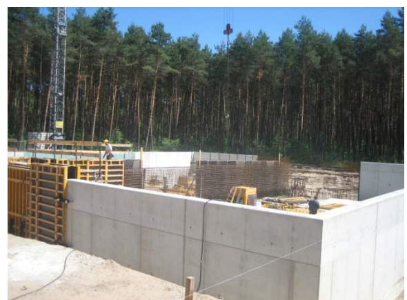
Wandbetonagen Absetzbecken in versetzten Abschnitten
