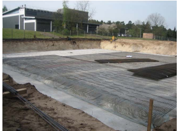
Baugrube mit Unterbeton zur Bewehrungsverlegung
