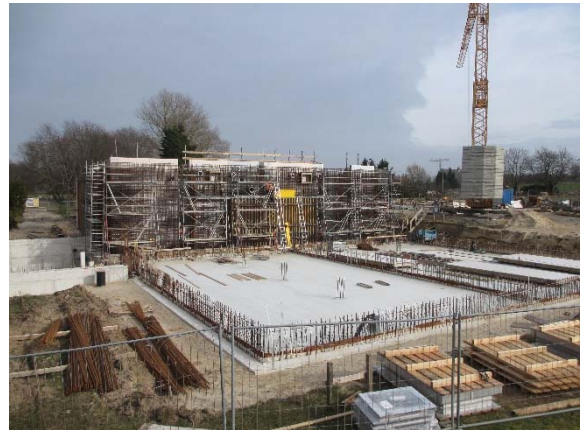
Betonarbeiten: Fertiggestellte Sohlen der Kammern 3 und 4 sowie Schalungs- und Bewehrungsarbeiten an den Wänden der Kammern 1 und 2
