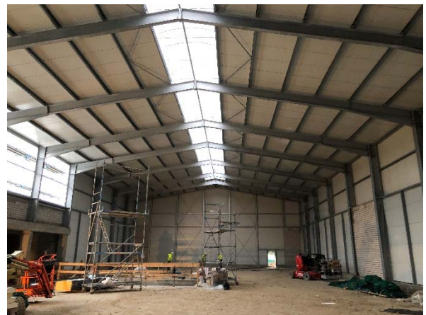
Behälterhalle im Bau
