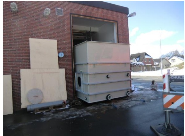
Einbringen oberer Kaskadenraum in WW-Gebäude
