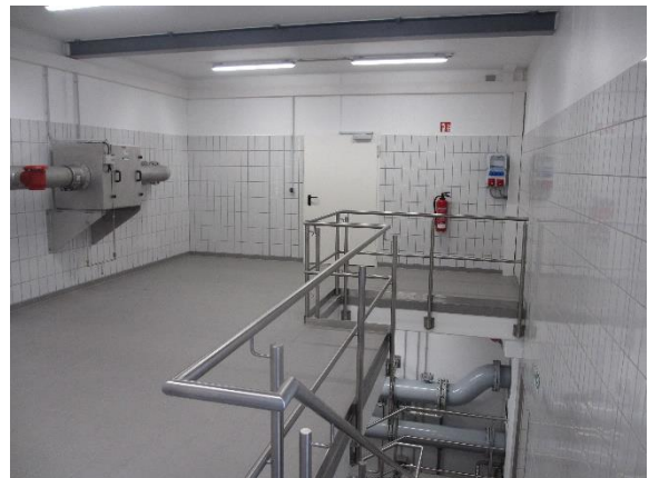
Einstiegsgebäude mit Zugang zum Bestandsgebäude
