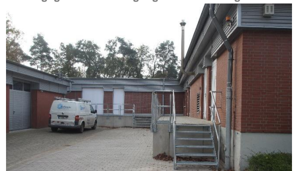
Ansicht Einstiegsgebäude (mittig) zwischen Bestandsgebäude (rechts u. links)
