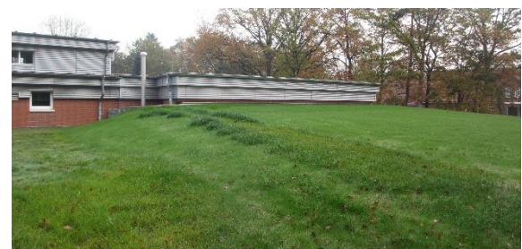
Rückansicht Einstiegsgebäude und erdüberdeckter Behälter
