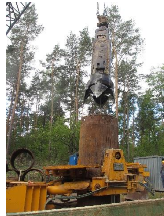
Bohrgerät (Drehtisch) mit Standrohr im Greiferverfahren
