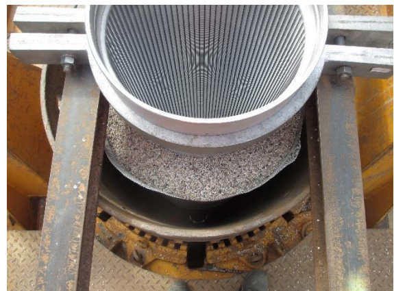
Einbau Wickeldrahtfilter DN 500 (Edelstahl) mit Abfangschelle und Innenschüttung in Kieskörben
