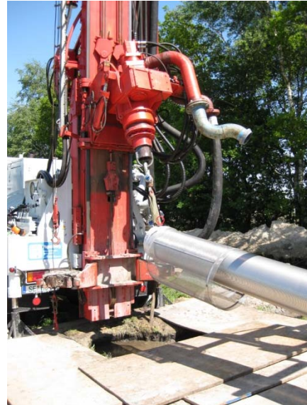
Filterrohr mit Schüttkörben für innere Schüttung
