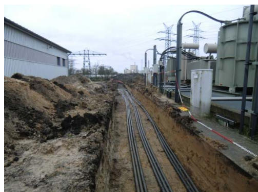
Ms- Kabelverlege- und Umschwenkarbeiten
