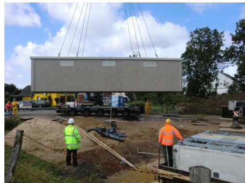
Aufbau der Betonfertigteilegebäude Station Nord vorne: Fundament und Kabelkeller
