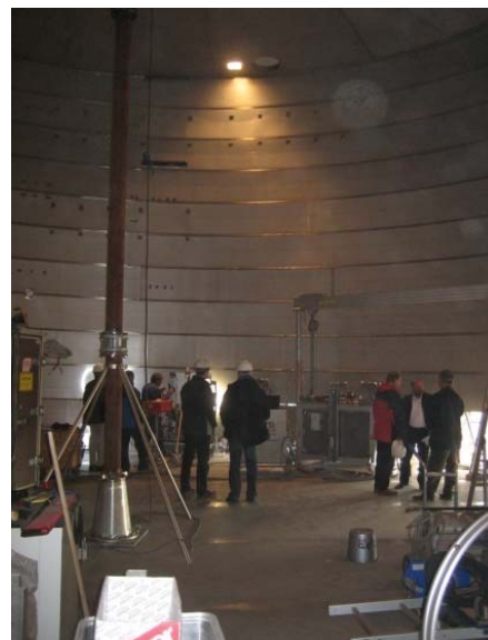
Schweißarbeiten am Behältermantel
