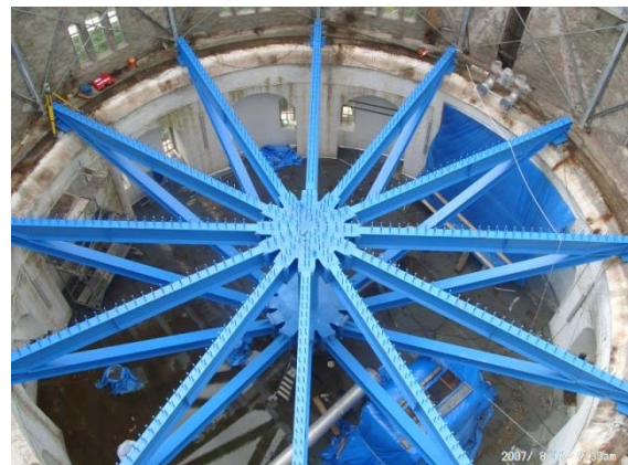
Fertiggestellte Stahlkonstruktion für den neuen Behälterboden
