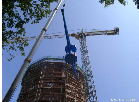
Montagearbeiten für die in Stahlverbundbauweise ausgeführte Behälterdecke in 40 m Höhe
